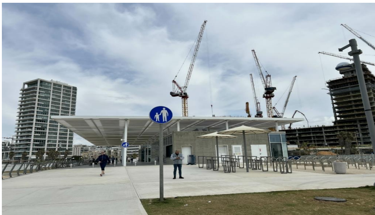
Grues de chantier à Tel Aviv (photo : KH)
