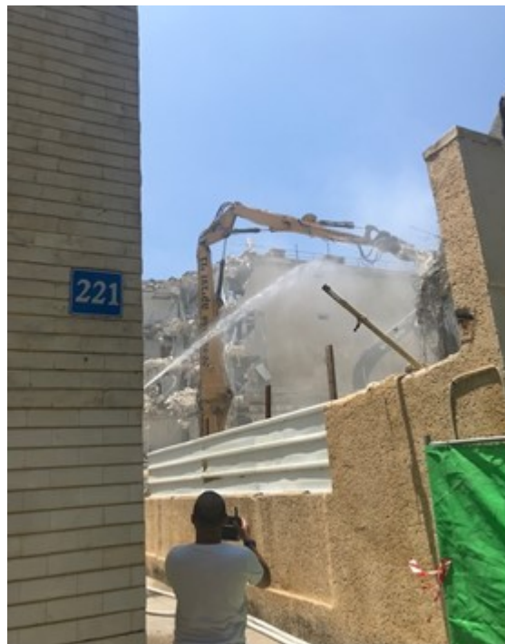
Un homme fait fonctionner un drone au-dessus d'un chantier à Tel-Aviv (photo : KHC)
